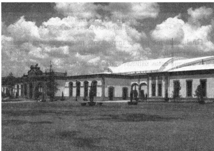
Centro Cultural y de Convenciones Bicentenario del estado de Durango.
